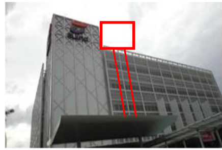
ภาพที่ 5 จุดติดตั้งตู้กรองอากาศ
